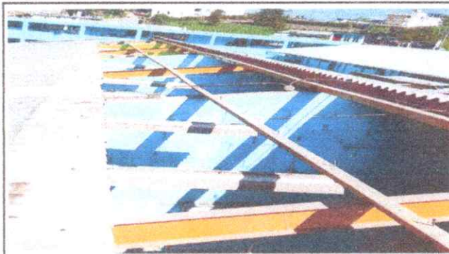
Foto 2: Se puede observar que en este momento empezán a desmontar la lamina existente
