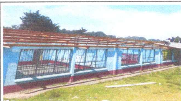
Foto 3: Se puede observar que en este momento empezán a desmontar la lamina existente
