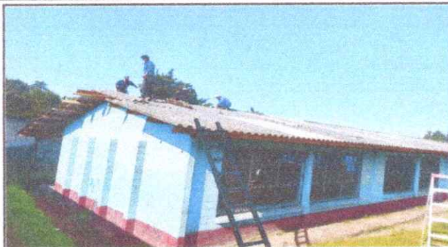
Foto 1: Se puede observar que en este momento empezán a desmontar la lamina existente
