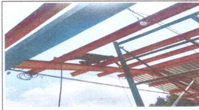
Foto 6: Se puede observar que se esta pintando la estructura existente.
